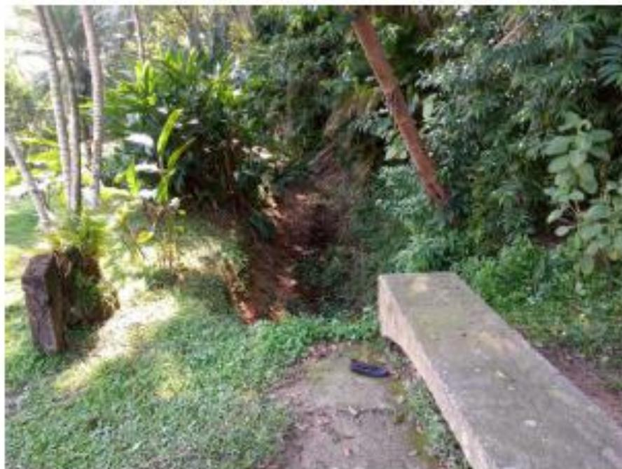
Foto 3 – Canal que capta o deságue da vala coletora de águas pluviais no setor direito da área avaliada. Foto tirada próximo à boca d'água da rua eng. Horácio Guedes Barreiro.
