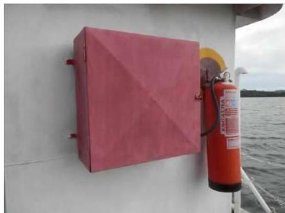
Caixa de incêndio e extintor CO<sup>2</sup> (6 kg)
