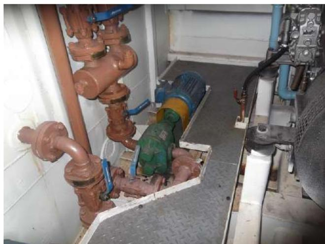
Foto 27 – Bomba Abast. Tanque Combustível
