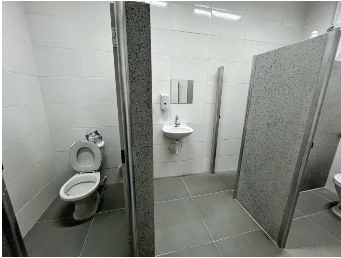
Banheiro feminino – piso térreo
